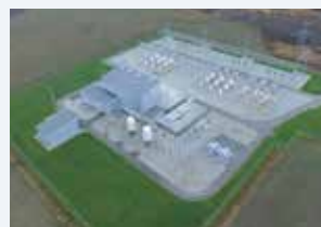
Püüsi converter station
